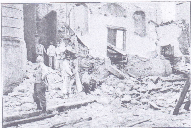
PARGHELLA. — TRABAJOS DE ESCOMBRERA PRATICADOS POR LOS INGENIEROS MILITARES.
